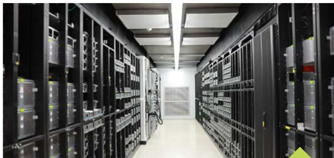
熱通道：熱空氣抽排及風壓、溫、濕度監測
